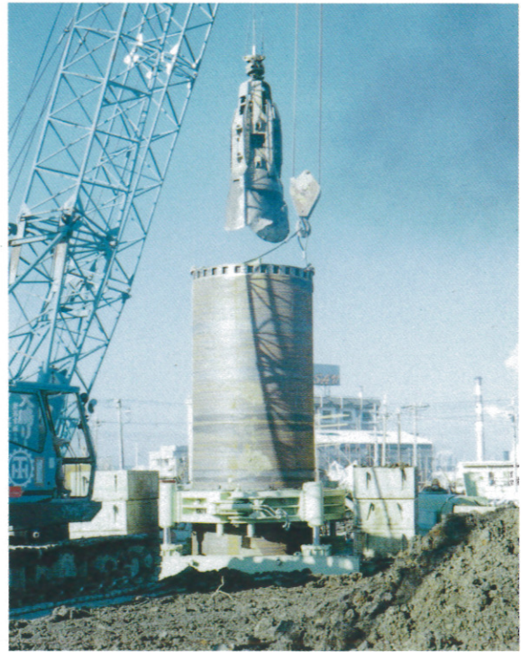
HC480T-3250型 リバースサーキュレーション工法
