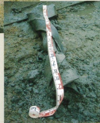
振り出されたH鋼杭▲
