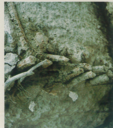
▼振り出された鉄筋コンクリート基礎
